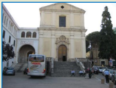
Ricreatorio della Comunità Ardorina con la facciata della Chiesa di San Francesco di Paola
