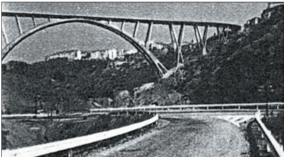
Catanzaro - Il ponte
